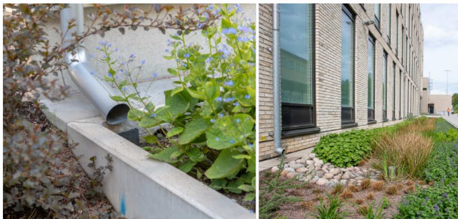
Figur 22. Till vänster: Upphöjd regnbädd vid förskola på Sunnerviksgatan (Foto: Lina Ekholm). Till höger: Nedsänkt regnbädd vid Kretslopp och vattens kontor Alelyckan (Foto: Lo Birgersson).
